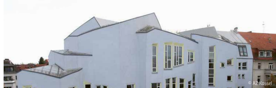
▲ Dachlandschaft, Gebäude des Arbeitszentrums Kassel
